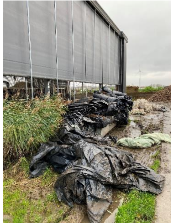
Figuur 7. Opslag materialen tegen stalgebouw aan biedt schuilplaats muizen en ratten.
