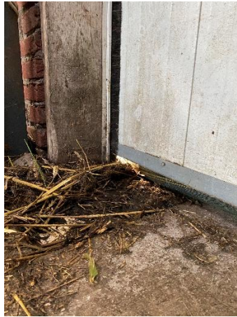
Figuur 4. Opening onder roldeur biedt toegang muizen en ratten.
