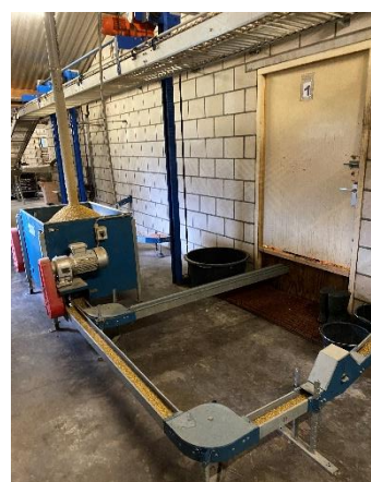
Figuur 11. Open voersysteem waardoor er te allen tijde voedsel voor muizen en ratten beschikbaar is (geldt ook voor varkens- en koeienhouderij).
