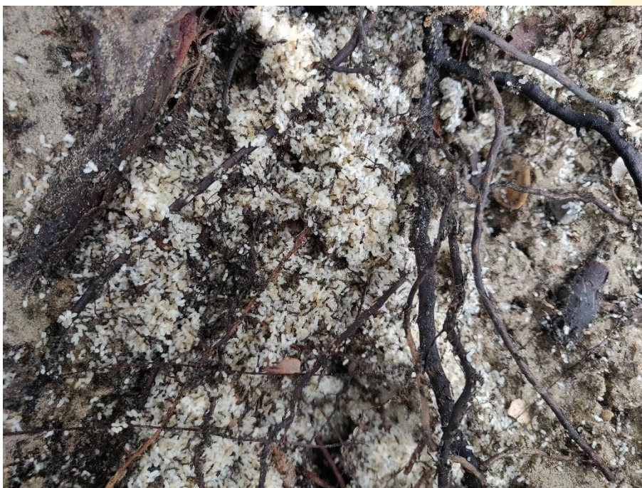
Foto 1: Grote hoeveelheden volwassen mieren en mierenbroed in uitgeholde ruimtes onder trottoirtegels.
